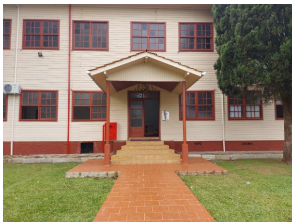
Fotografia 1: Acesso principal da edificação - Novo acesso deverá seguir padrão
