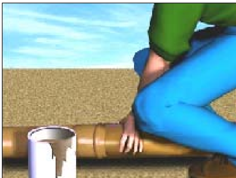
Figura 7.3 - Encaixe Ponta e Bolsa
