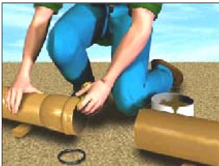
Figura 7.1 - Limpeza com estopa
