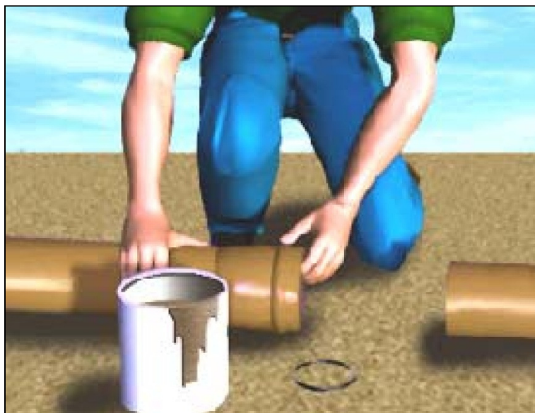
Figura 7.2 - Lubrificação da Ponta e Bolsa
