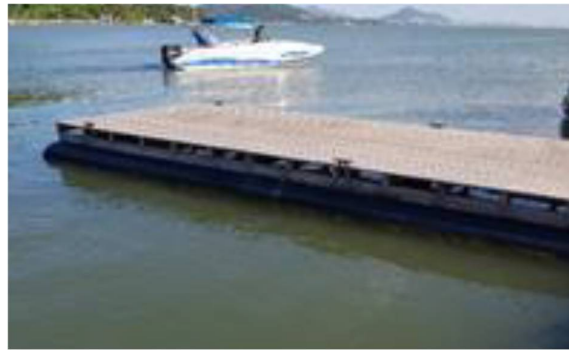
Imagem 01 Pier Flutuante em PEAD
