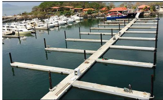
Imagem 02 Pier Flutuante em Concreto
